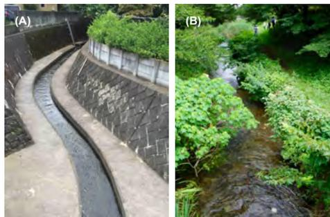
図 1 (A) 上流区間（コンクリート護岸）と (B) 下流区間（多自然護岸）の河道
