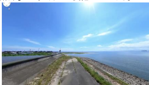
図1 ドローンで撮影した雲出川の堤防
